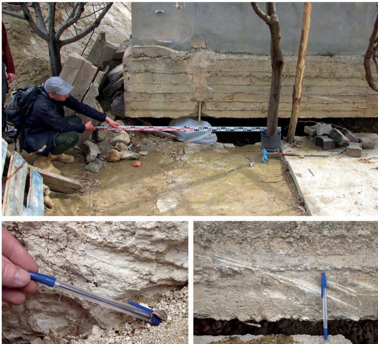
Рис. 9. Левосдвиговое смещение на 1.71 м и поднятие юго-восточного крыла на 0.55 м стены дома над сейсмогенным разрывом 06.02.2023 г. Дом поднят и смещен влево относительно облицовки грунта возле дома. Косяя штриховка на известняке рядом с домом (слайд 1, слева) и на бетоне фундамента (слайд 2, справа) указывает на преобладание левого сдвига над вертикальным смещением.
