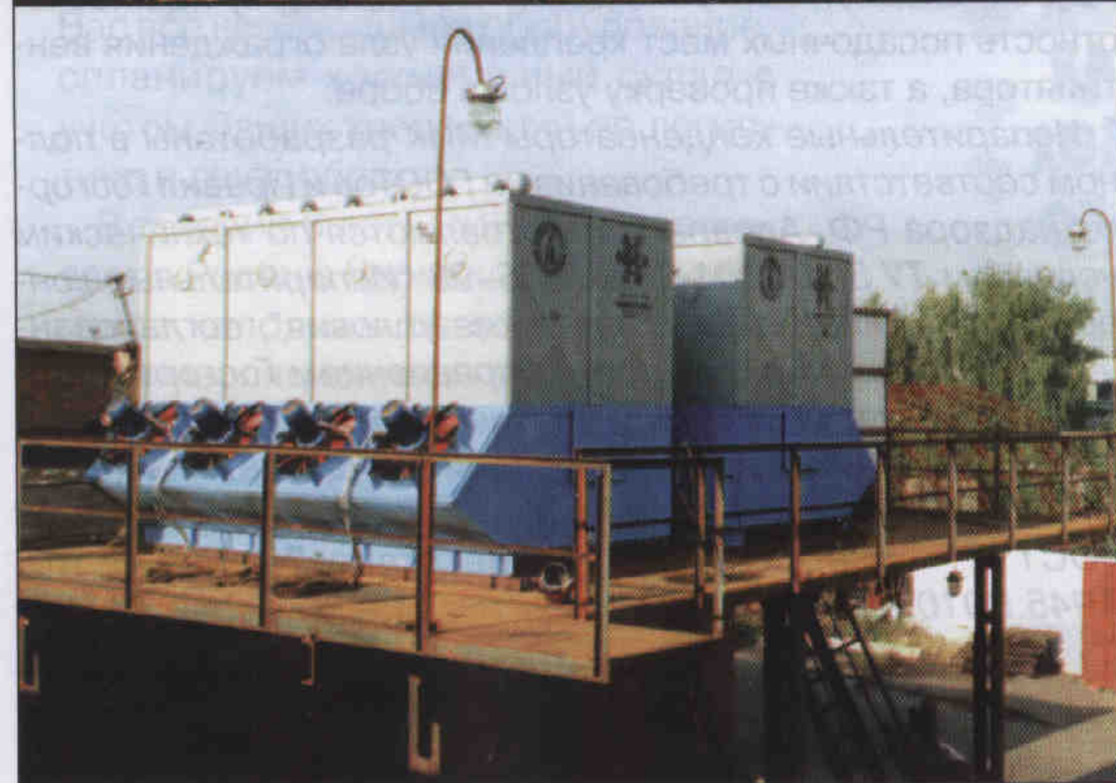
Испарительные конденсаторы МИК4-400 на московских плодовоовощных базах "Красная Пресня" (вверху) и "Ростокино" (внизу) в Москве
