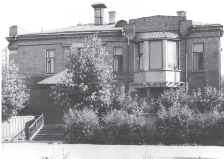
Фасад корпуса № 1, 1950-е гг.
