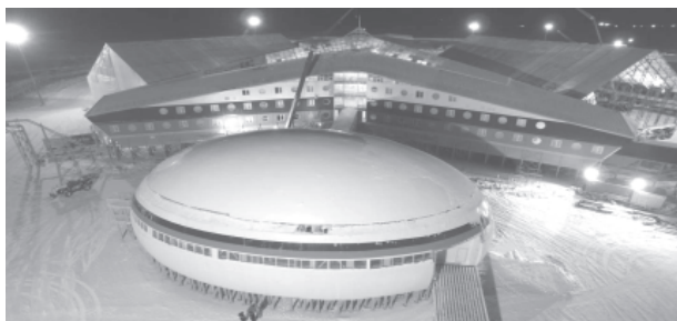
Административно-жилой комплекс с медицинским блоком и зоной материально-технического обеспечения на о. Земля Александры архипелага Земля Франца-Иосифа
