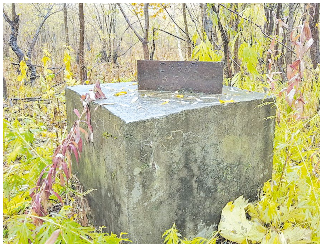
Рис. 3. Затампонированная скважина, от которой исследовано загрязнение (съемка 2022 г.).
