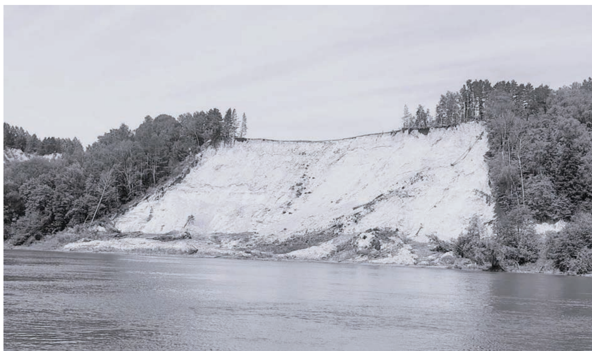
Рис. 8. Оползень на нижнем Иртыше (ниже устья р. Ишим). Фото автора.
