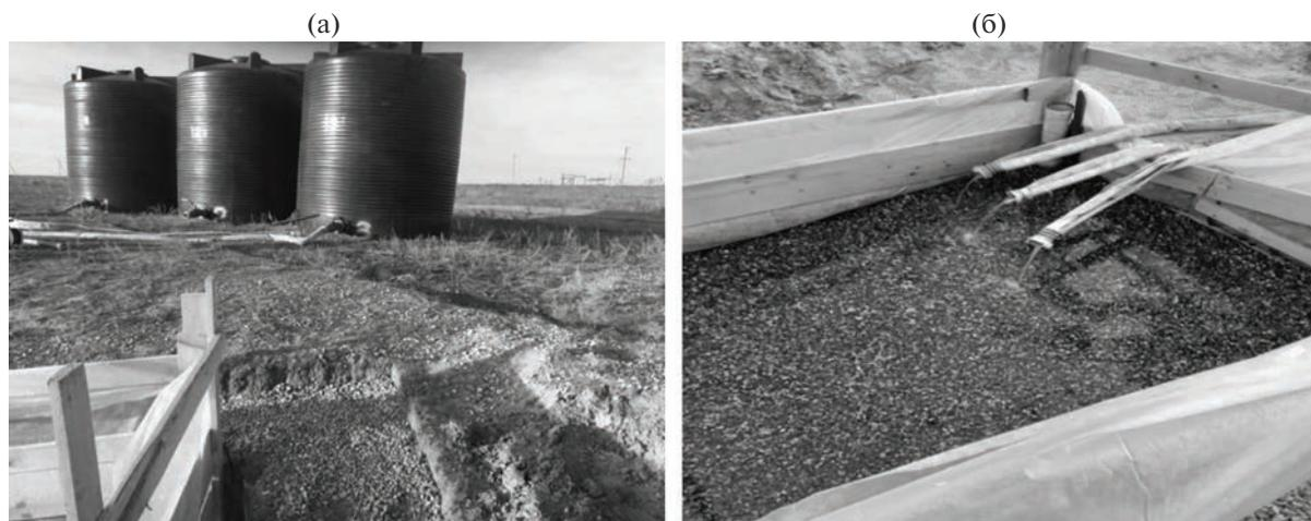
Рис. 5. Подача воды из заполненных емкостей (30 м<sup>3</sup>) в инфильтрационный бассейн с отрегулированным расходом (для автоматического заполнения в течение суток).
