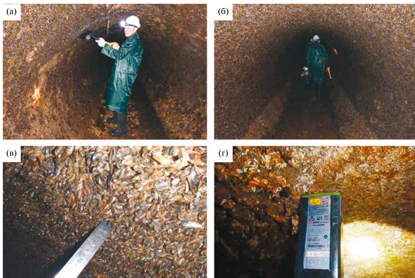
Рис. 2. а, б — процесс пробоотбора микроперифитона в бетонном тоннеле ВТЭЦ-2 на участке с мощным мидиевым обрастанием, в — приближенный фрагмент мидиевого обрастания на поверхности тоннеля, г — лазерный дальномер “Leica DISTO A8” на фоне макрообрастания.
