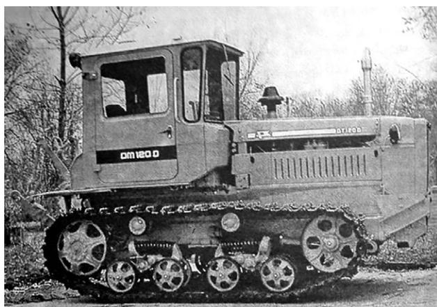
**Рис. 15.** Экспериментальный трактор ДТ-120Д с дизелем Д-440 с двумя уровнями мощности.
