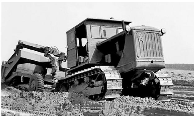
**Рис. 4.** Гусеничный промышленный трактор «Сталинец-80» (С-80).
