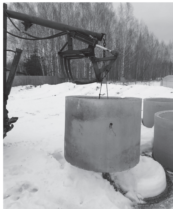
Рис. 10. Фронтальный погрузчик в работе с железобетонными кольцами
