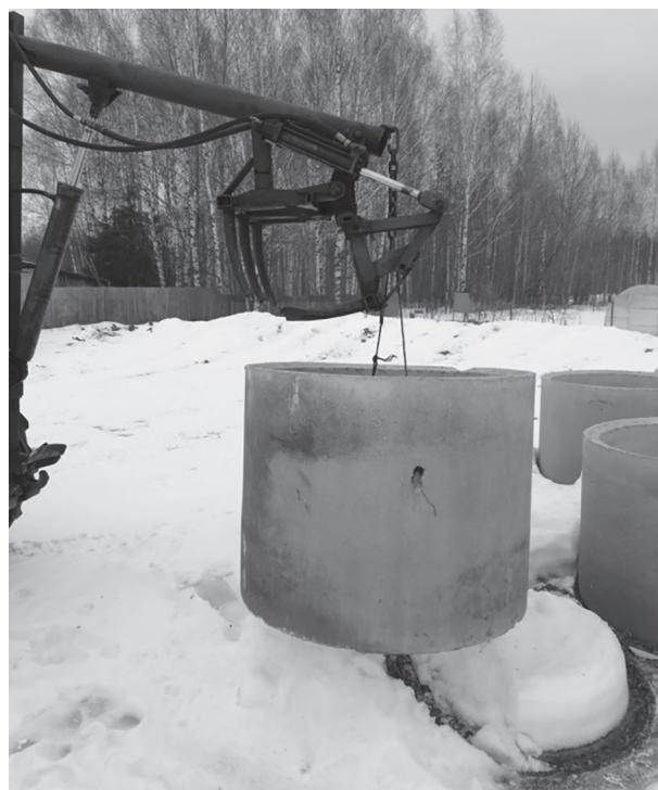
**Рис. 10. Фронтальный погрузчик в работе с железобетонными кольцами**
