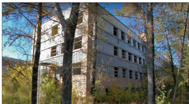
Рис. 1. Здание НИИасбестцемента в г. Воскресенске Московской области, облицованное экструзионными стеновыми панелями
