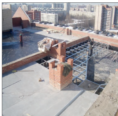
Рис. 4. Утепление пенобетоном кровли 25-этажного здания в Санкт-Петербурге Fig. 4. Insulation of the roof of a 25-story building in St. Petersburg with foam concrete
