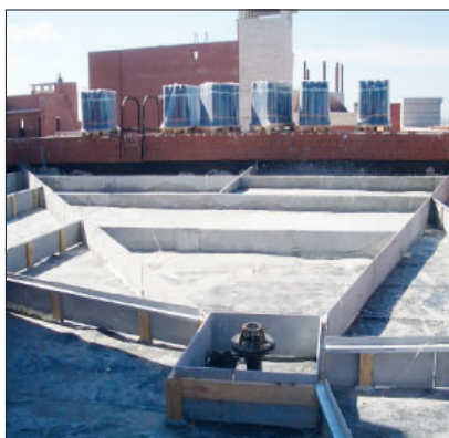
Рис. 4. Утепление пенобетоном кровли 25-этажного здания в Санкт-Петербурге Fig. 4. Insulation of the roof of a 25-story building in St. Petersburg with foam concrete
