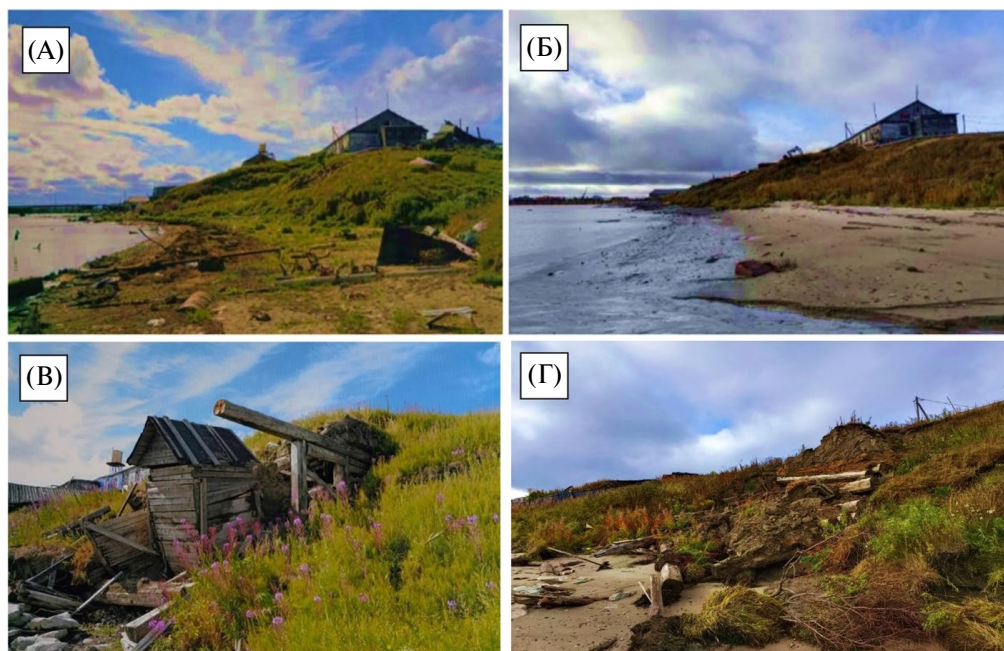
Рис. 3. А — Состояние берега вблизи мерзлотника в 2016 г., вид с северо-востока. Наблюдаются осушка и участки лайды. Б — Состояние берега вблизи мерзлотника в 2023 г., вид с северо-востока. Лайда размывта и замещена маломощным пляжем. В — Вход № 3 в 2016 г. Не используется в связи с угрозой обрушения и переоборудован в вентиляхту. Г — Вход № 3 в 2023 г. Ликвидирован.
