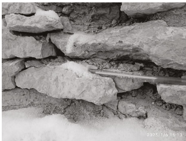
Рис. 4. Сильно биотурбированные микритовые известняки в облицовке наружного участка нижней части башни Луковка.
