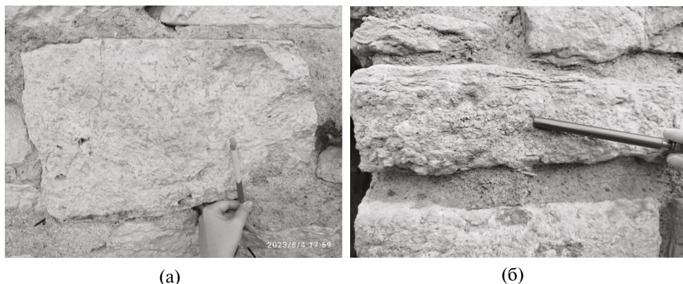
Рис. 2. Сильно биотурбированные микритовые и криноидные известняки: (а) — биотурбированные известняки в фундаменте церкви священномученика Тимофея Газского, XIV в., Довмонтов город; (б) — криноидные известняки в стене Окольного города, башня Глухая, XVI в.
