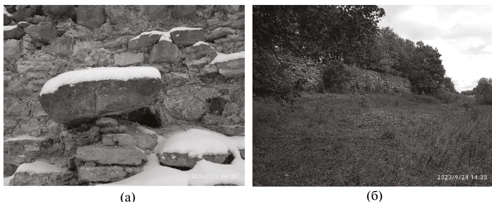
Рис. 6. Сохранившаяся стена Гдовской крепости: (а) — фрагмент сохранившейся стены с хорошо видимым чередованием валунов магматических пород и известняковых плит; (б) — общий вид сохранившейся стены.
