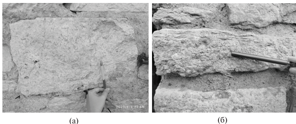
Рис. 2. Сильно биотурбированные микритовые и криноидные известняки: (а) — биотурбированные известняки в фундаменте церкви священномученика Тимофея Газского, XIV в., Довмонтов город; (б) — криноидные известняки в стене Окольного города, башня Глухая, XVI в.
