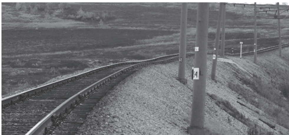
Рис. 3. Высокоамплитудная протяженная просадка третьего типа (на заднем плане), сформировавшаяся по высокой насыпи на пересечении железной дороги с водотоком над таликовой зоной; на переднем плане — малоамплитудная просадка первого типа на участке примыкания насыпи к блоку-бугру (2022 г.).
