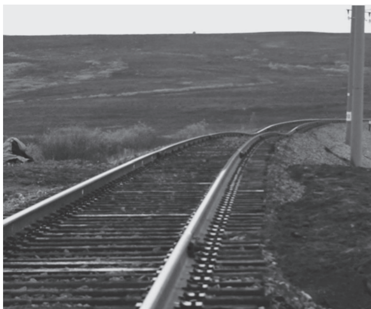
Рис. 2. Высокоамплитудная просадка второго типа, сформировавшаяся предположительно в результате оттаивания льдистых грунтов на границе блока-бугра (2022 г.).
