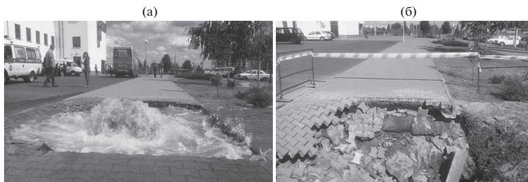
Рис. 5. Прорыв водопроводной трубы, вызвавший суффозионный размыв грунта (а), и его последствия вблизи Ледового дворца в Гомеле, 2013 г. (б) [6].
