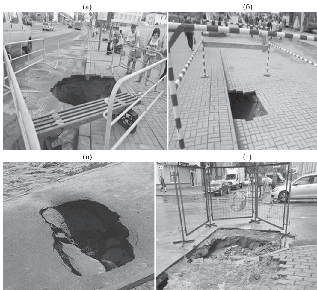
Рис. 6. Деформации тротуаров, вызванные суффозией, в: а, б — Витебске вблизи летнего Амфитеатра (2011 и 2012); в — Гомеле вблизи парка “Фестивальный” (2020); г — Бресте на перекрестке улиц Мицкевича и Куйбышева (2020) [1, 5, 17, 18].
