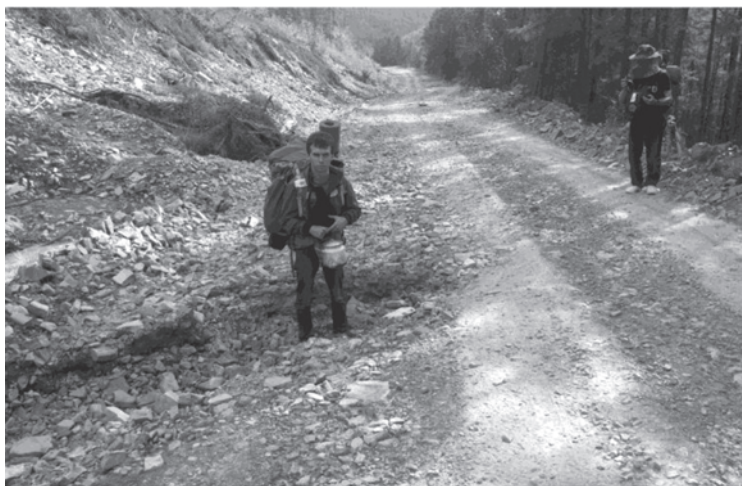
Рис. 2. Исследуемый участок с иллюстрацией размыва полотна дороги эрозионными процессами (фото Н.А. Гурьянова).
