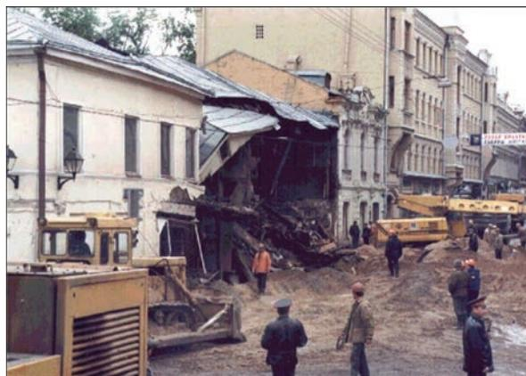
**Рис. 1.** Разрушение здания, вызванное провалом, образовавшимся в результате выноса водонасыщенных несвязных пород в подземную горную выработку (Москва, 1998). Фото В.П. Хоменко [14].
