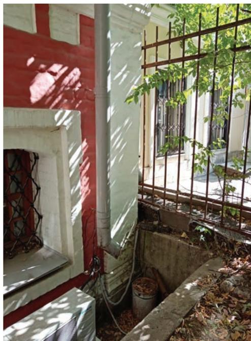
Рис. 2. Организация рельефа при реставрации Палат XVII в. и восстановлении исторических отметок главного фасада. Отмечаются нарушение водостоков, замокание стен, образование трещин на фасаде.
