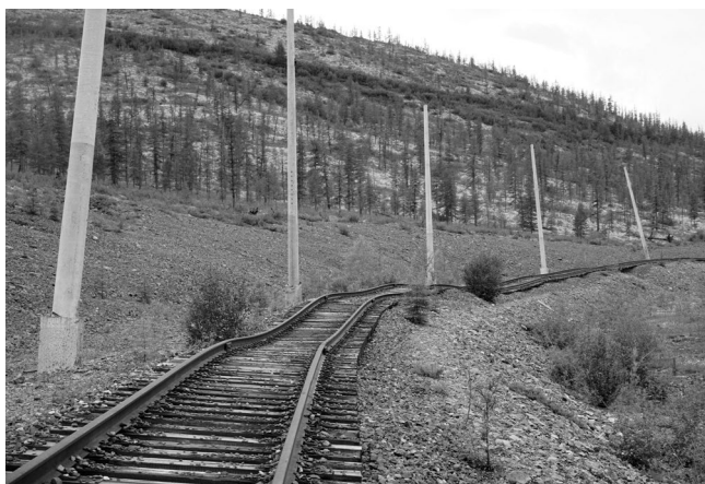
Рис. 15. Волнообразные просадки участка железнодорожной ветки Новая Чара — Чина (68-й километр дороги), вызванные термокарстовым процессом (фото А. Кулакова).
