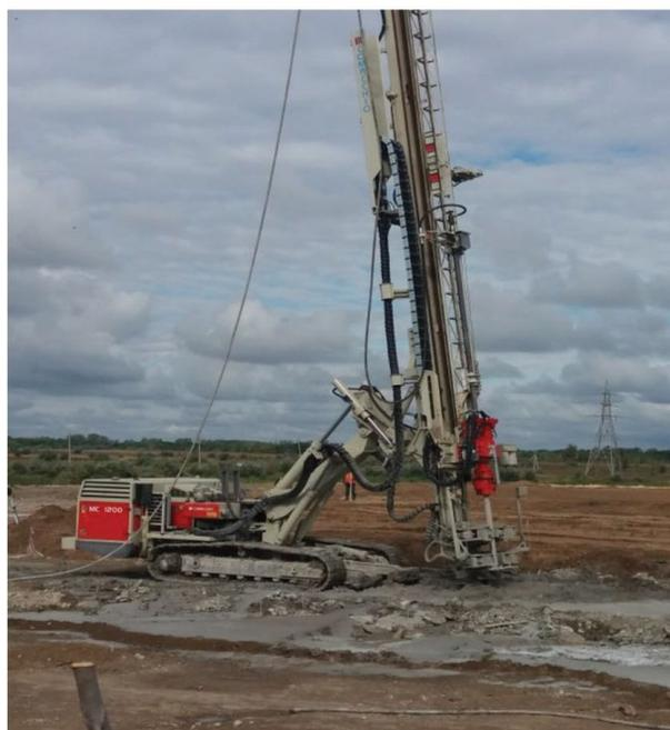
**Рис. 2.** Отдельные узлы сооружений высоконапорной реагентной очистки пород от углеводородных загрязнений: а – площадка нагнетательно-добывающих скважин с превенторами; б – высоконапорная насосная станция с реагентным хозяйством; в – узел приготовления раствора реагентов; г – передвижной высоконапорный экструдер (Jet – нагнетатель).
