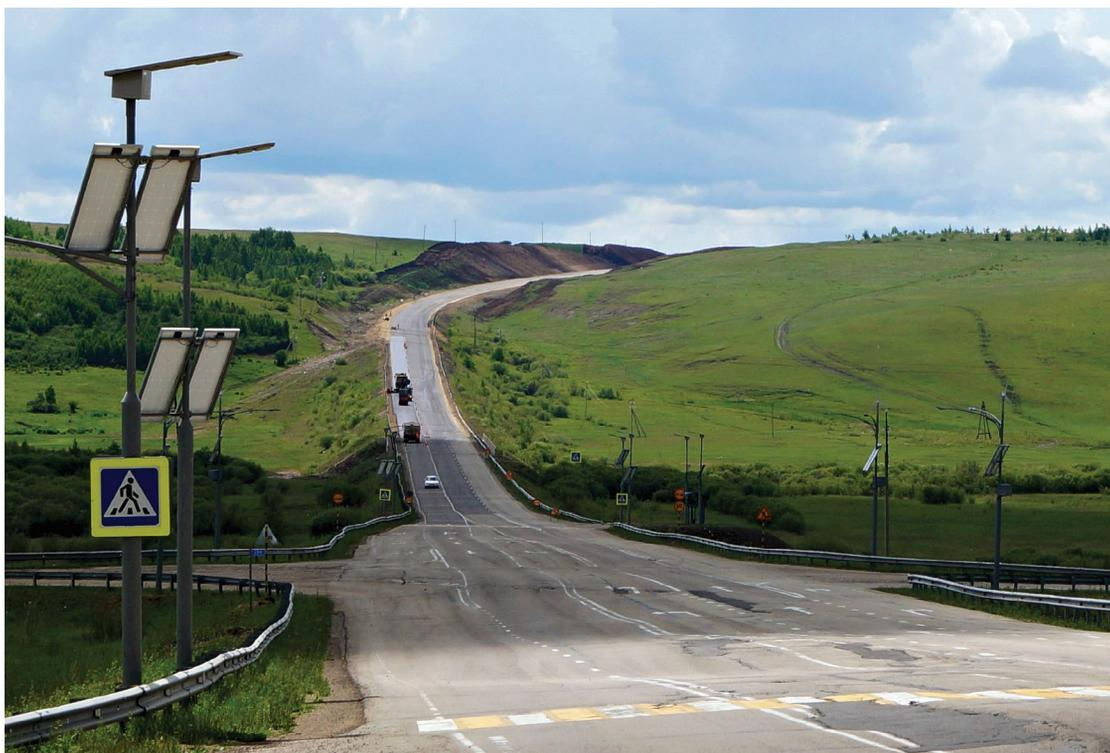
Рис. 2. Осадки земляного полотна на ключевом участке 288 км автодороги “Амур” (фото Р.Р. Давлетовой).
