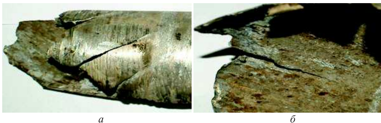
Рис. 1. Области разрушения ЛБТ, \times 0,3 : а – наружная поверхность; б – внутренняя поверхность
