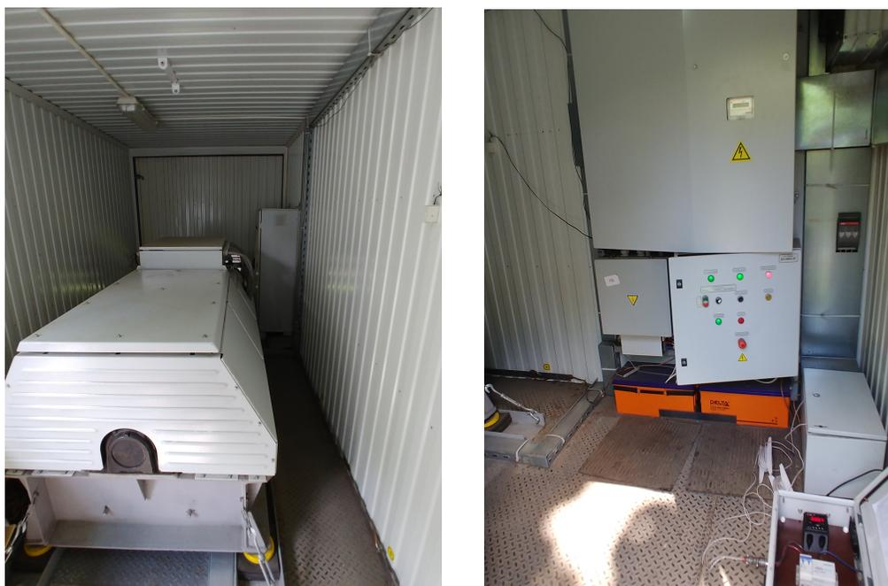
Рис. 2. Маховичный накопитель энергии НКЭ-3Г и его шкаф управления с двунаправленным счетчиком энергии СКВТ-Ф610
