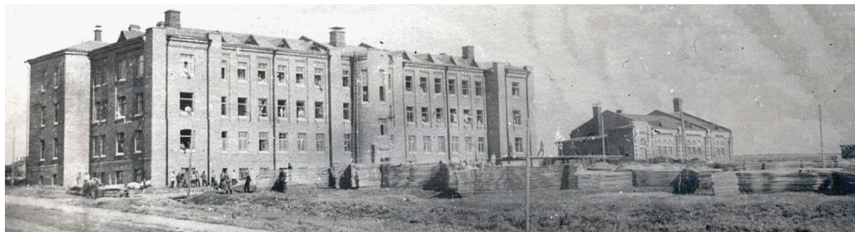
Рис. 3. Восстановление больницы «Ильича» и зданий прачечной, кухни и служб на заводе Баррикады [7]
