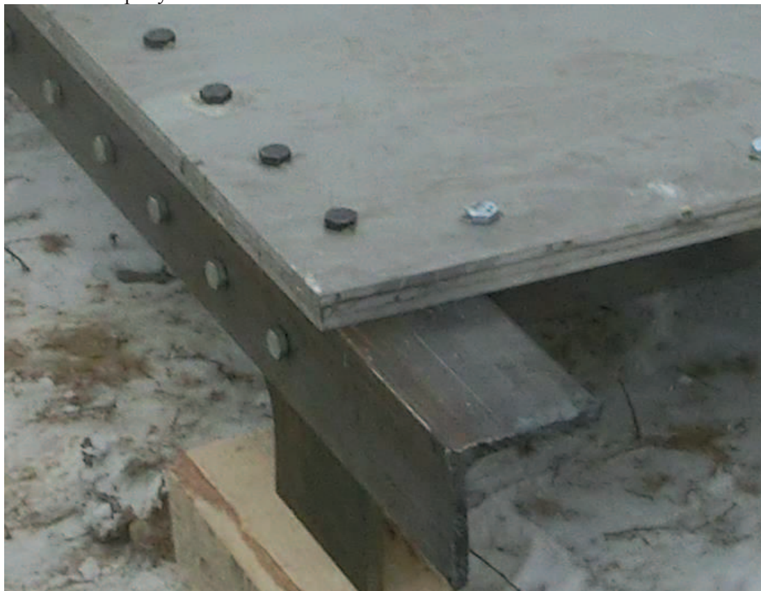
Рисунок 1. Болтовое соединение частей конструкции
