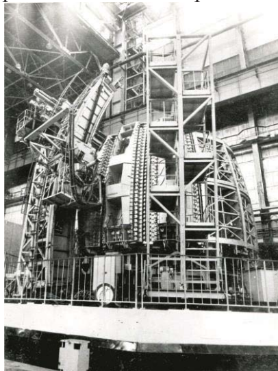
Рисунок 3. Установка автоматической гелио-дуговой сварки оживальных швов баков
