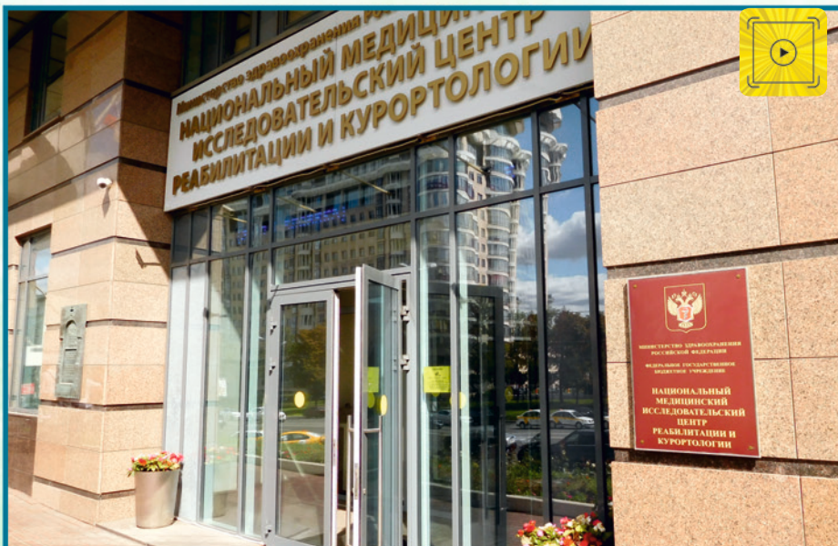
Научно-клинический центр на Новом Арбате /г. Москва/
