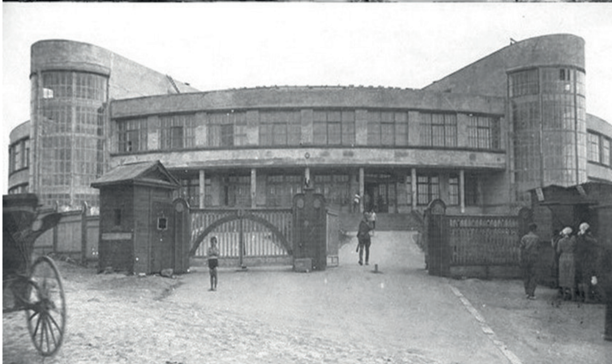
Рис. 8. Вид сверху при реставрации и архивное фото главного входа фабрики-кухни в Самаре
