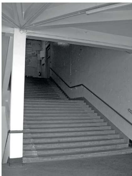
Рис. 6. Одна из главных лестниц фабрики-кухни ГАЗ №1
