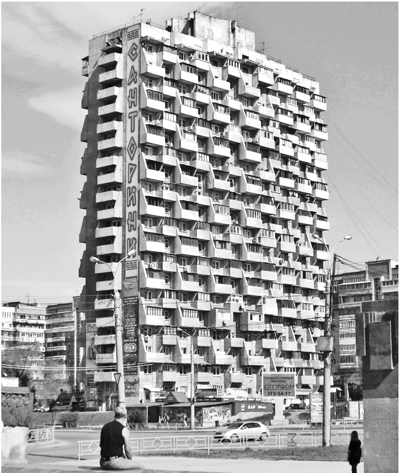
Рис. 1. Жилой дом по адресу: г. Самара, пр. Ленина, 14 А (архитектор А.Н. Белоконь).
