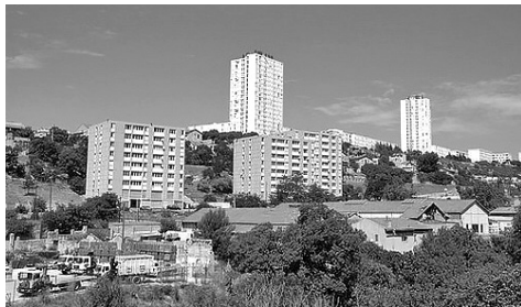
Рис.23. Комплекс Les Créneaux перед сносом в 2009 г. [19]
