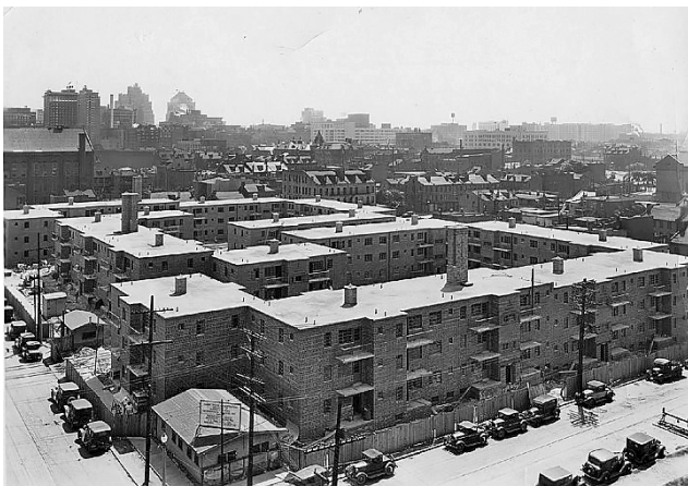
Рис. 2. Нейборхуд Гарденс на завершающей стадии строительства, 1935 г. [3]
