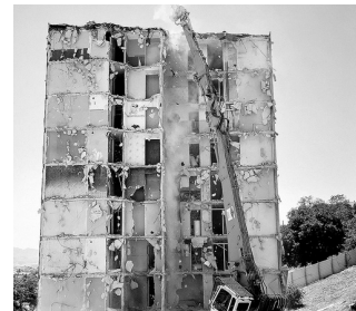
Рис. 24. Снос одного из домов (фото Y.Lamoulère)
