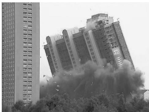
Рис. 3. Общий вид жилого комплекса Red Road Flats в Глазго, Шотландия (фото Том Манли, 2010 г.) и снос направленным взрывом одного из зданий (фото SWNS, 2014 г.)
