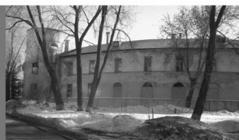
ii. Современный вид: здание при реконструкции в 1944 г. потеряло витражи и центральный вход
