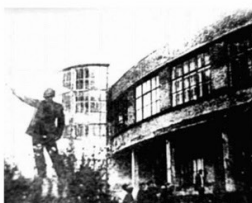
i. Здание до реконструкции -- большие витражи, центральный вход
