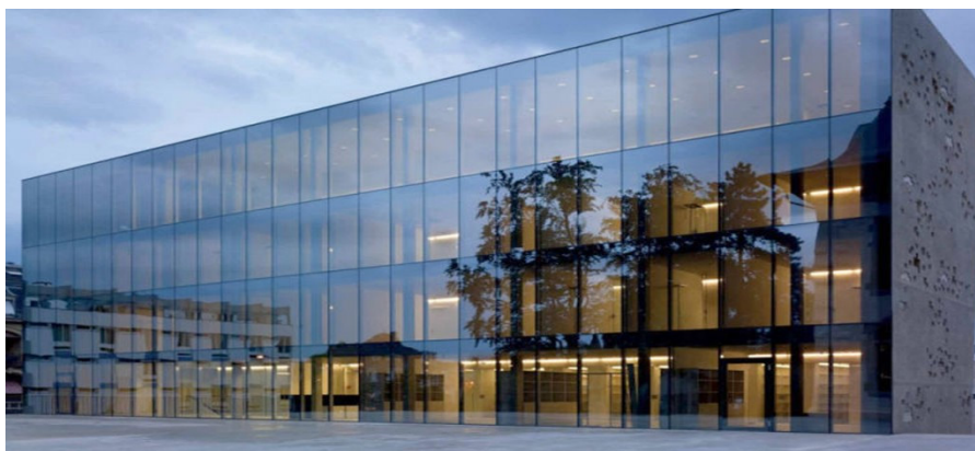
Рис. 3. Структурное остекление [2]
