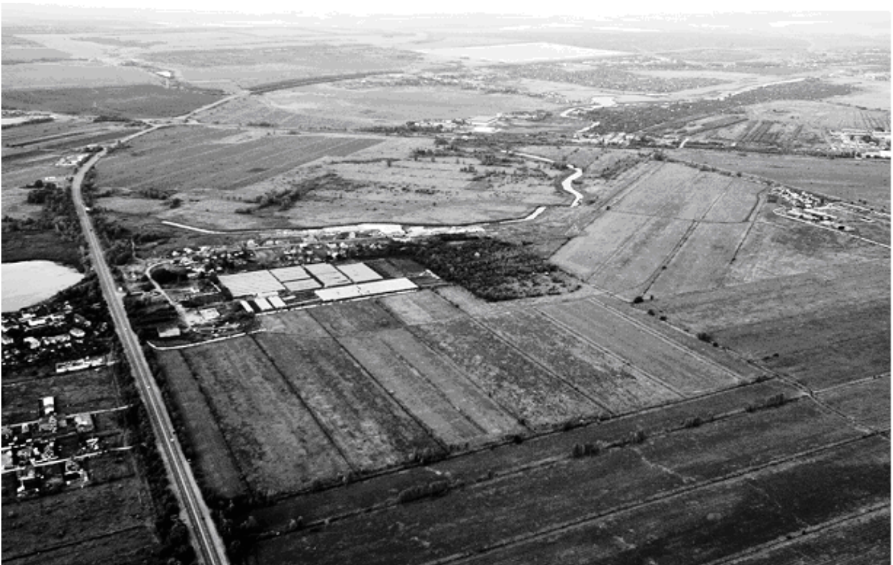
Рис. 2. Территория «Южного города» перед началом строительства, 2012 г.
