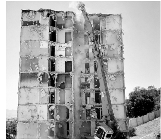
Рис. 24. Снос одного из домов (фото Y.Lamoulère)
