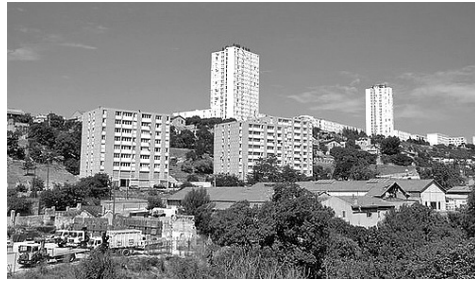
Рис.23. Комплекс Les Créneaux перед сносом в 2009 г. [19]
