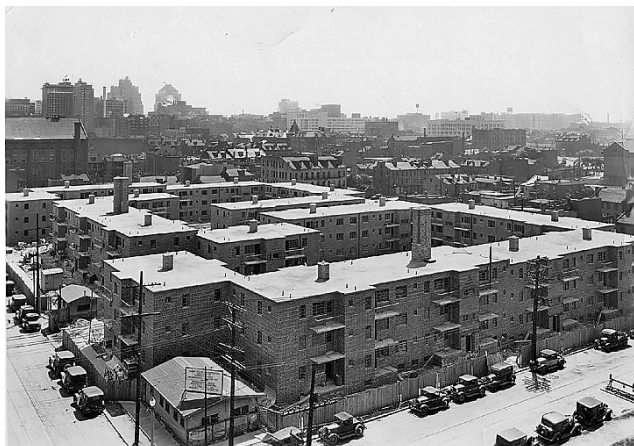
Рис. 2. Нейборхуд Гарденс на завершающей стадии строительства, 1935 г. [3]
