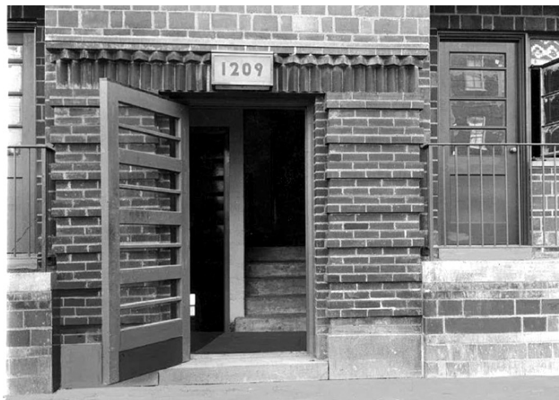
Рис.3. Главный вход в жилой комплекс и балкон с декоративной кирпичной кладкой, 1985 г. [3]
