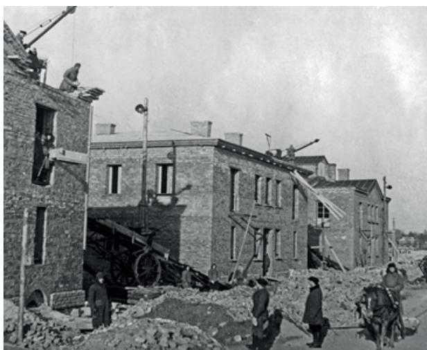
Необходимость строительства жилья в кратчайшие сроки опиралась на рационализаторские проекты и предложения в архитектуре и проявилась в интересе к сборным экономичным конструкциям, местным строительным материалам, упрощенным технологиям, унифицированным процессам и формам. В условиях дефицита кадров, оборудования и времени массовое жильё возводилось малоэтажным (рис. 3) [1].
