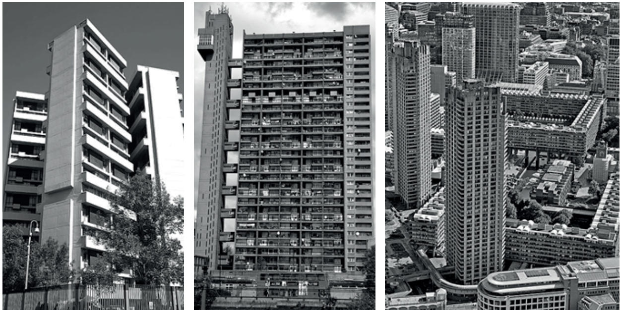
Рис. 7. Успешные сегодня высотные жилые комплексы Лондона: Keeling House (Арх. Дэнис Ласдэн, 1954-1957 г.), Trelick Tower (Арх. Эрнэ Голдфингер, 1968-1972 г.), Barbican Estate (Арх. Пупер Чемберлен, Джеффри Пауэлл, Кристоф Бон; 1969-1976 г.)
