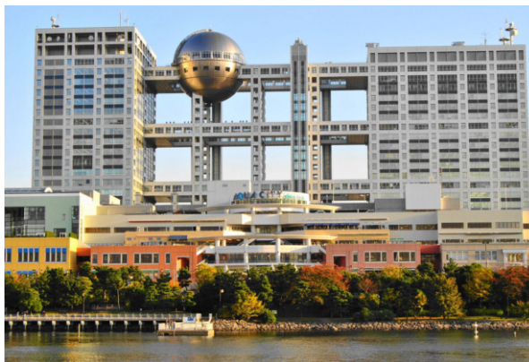
Рис. 6. Здание Fuji TV в Токио
