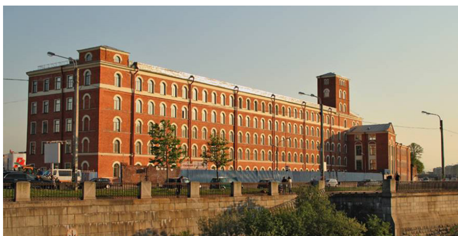
Рис. 6. «Ткачи». Общий вид со стороны Обводного канала
