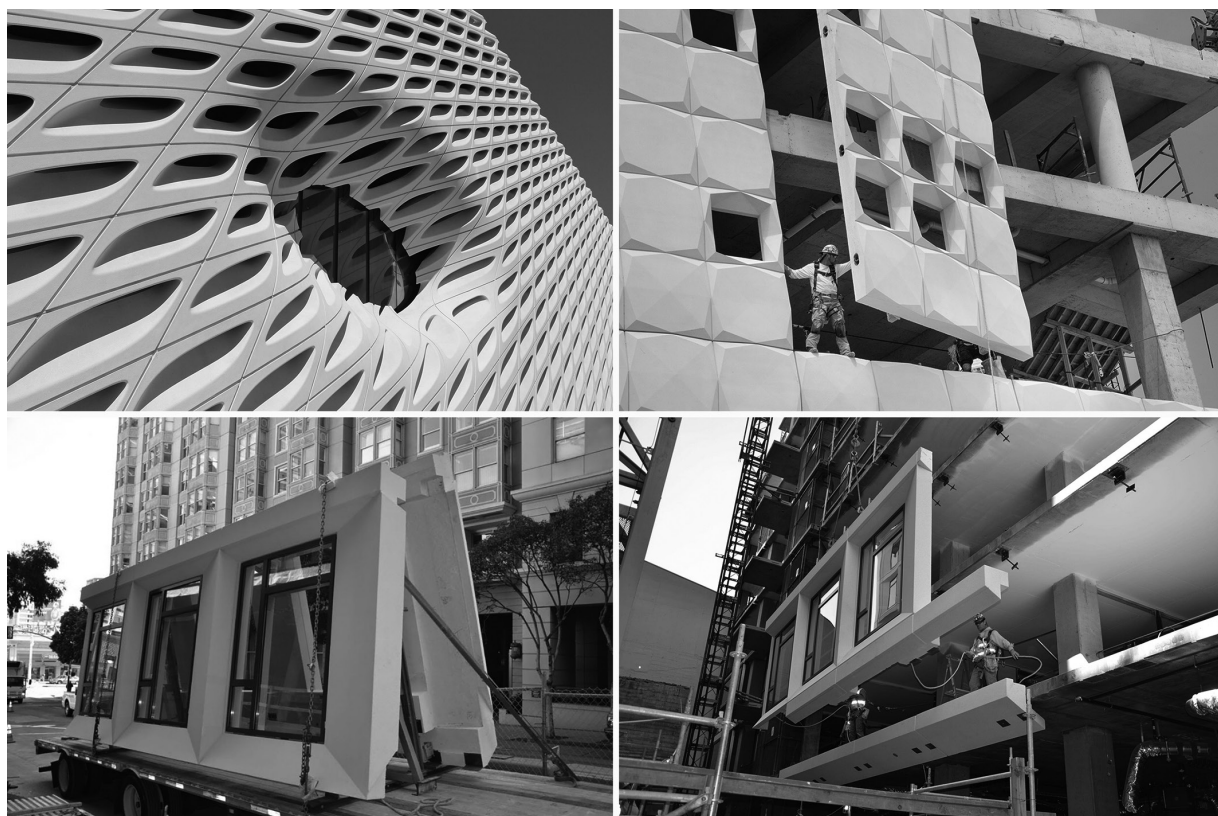
Рис. 3. Примеры использования стеклофибробетона в фасадных панелях
