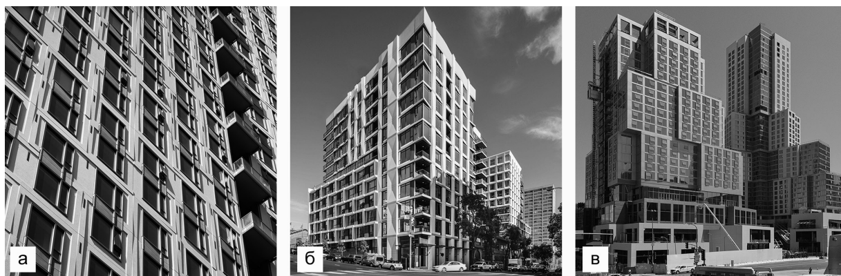
Рис. 6. Зарубежный опыт применения архитектурного сборного железобетона: а – «17th & Broadway» (г. Окленд, США); б – «The Rockwell, SF-Bay Area» (г. Сан-Франциско); в – «Grand LA» (г. Лос-Анджелес)
