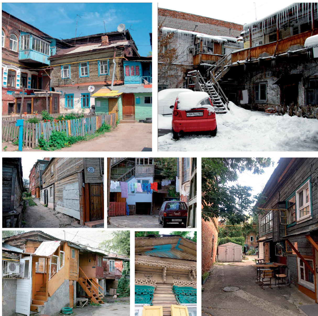
Рис. 2. Анонимная архитектура самарских дворов (фото: из книги «The Samarsky Yard», авторы Йорн Шимман, Отто Вейерс, Лариса Арарипе Рэнд, Евгения Репина, Сергей Малахов, Александр Гнилomedов, из брошюры «Тотальный музей самарского двора», авторы Евгения Репина, Ксения Горина, Снежана Лашенко и др.)
