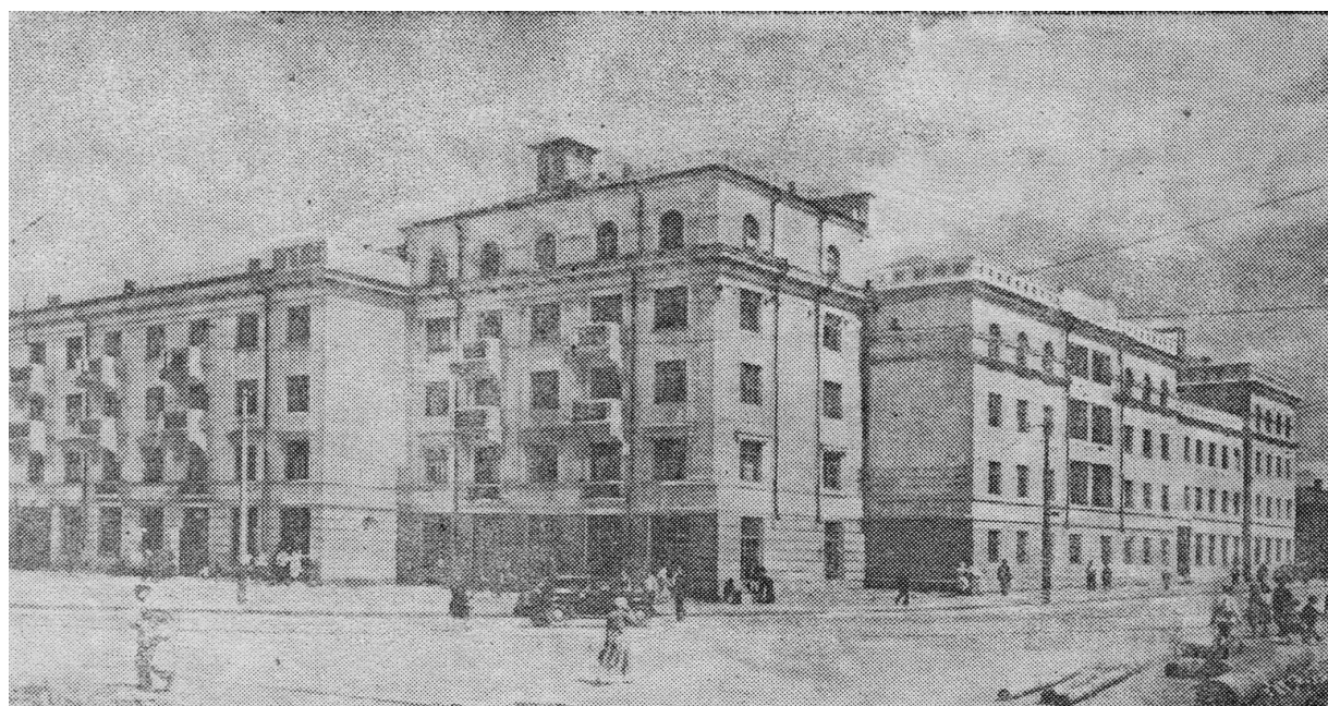
Рис. 7. Жилой дом трампарка на ул. Полевой, архитекторы А.Л. и С.Л. Каневские, В.Н. Бузин, 1935-1938
