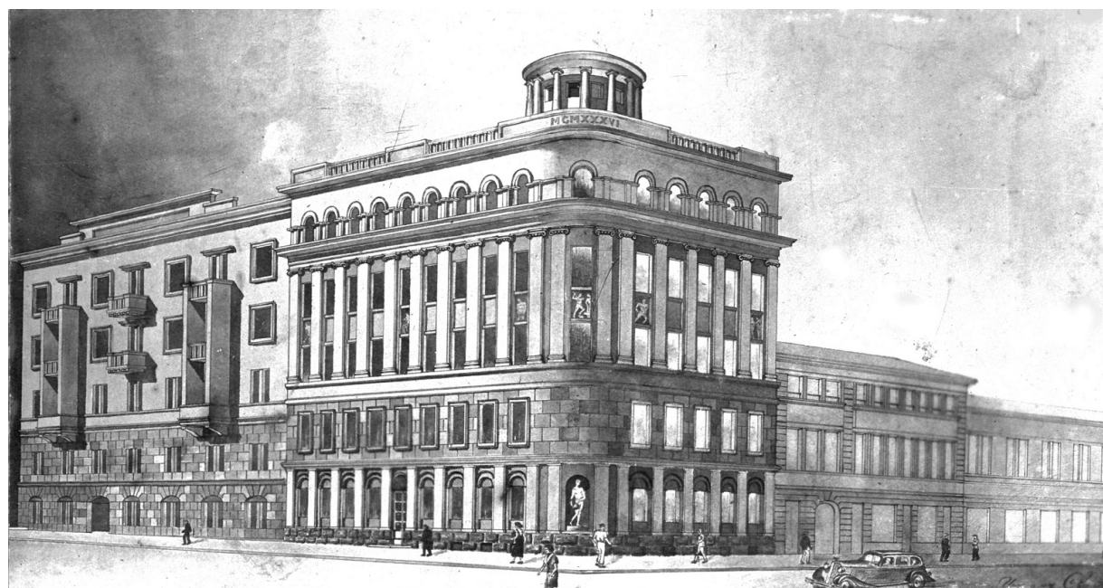
Рис. 5. Жилой дом Станкостроительного завода на Площади Революции, архитекторы С.Л. Каневский, А.Л. Каневский, 1936
