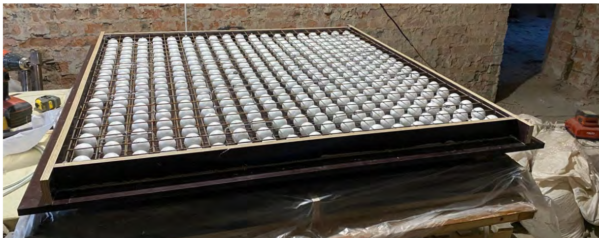
Рис. 1. Общий вид опалубки с установленными сетками нижнего, верхнего армирования и сферическими пустотообразователями
