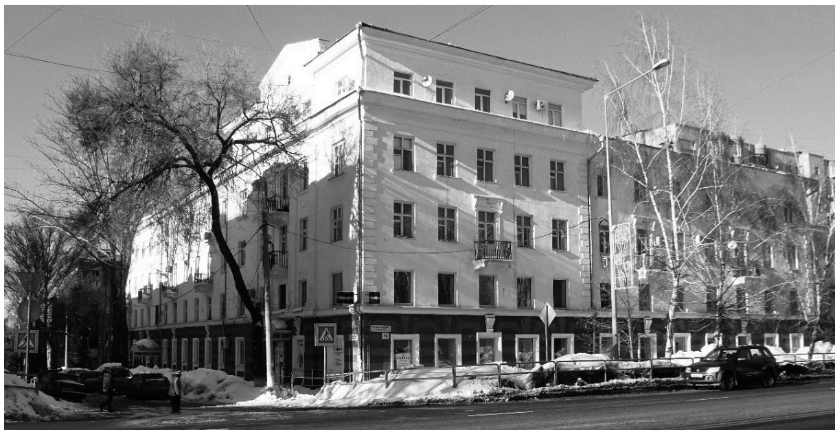
Рис. 1. Вид на здание со стороны перекрестка улиц Ново-Садовой / Невской
