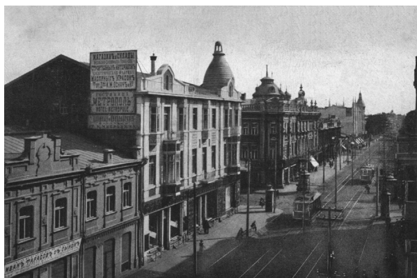
Рис. 2. Екатеринбург. Вид на юг ул. Красной, между ул. Полицейской (совр. – ул. Гоголя) и ул. Екатерининской (совр. – ул. Мира), начало XX в. [9]
