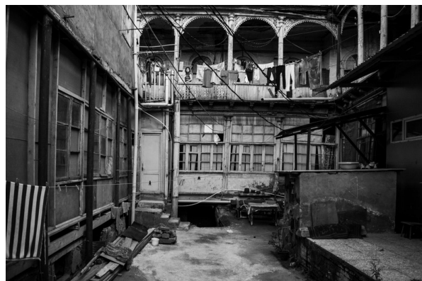
Рис. 11. Тбилисский двор. Традиционные крытые террасы-галереи с декоративной аркадой – самая характерная особенность организации этого пространства – одновременного частного и соседского, коллективного
