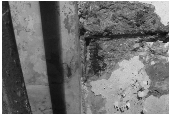
Рис. 4. Коррозия рабочей арматуры и хомутов колонн здания столовой в пос. Заозёрное г. Евпатории
