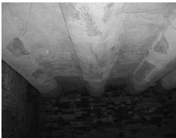
Рис. 8. Перекрытие по деревянным балкам над подвалом здания постройки конца XIX в. по ул. Куйбышева, д. 75
