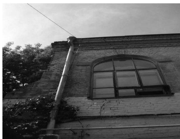
Рис. 6. Кирпичная циркулярная перемычка (здание 1908 г. по ул. Венцека, д. 61)
