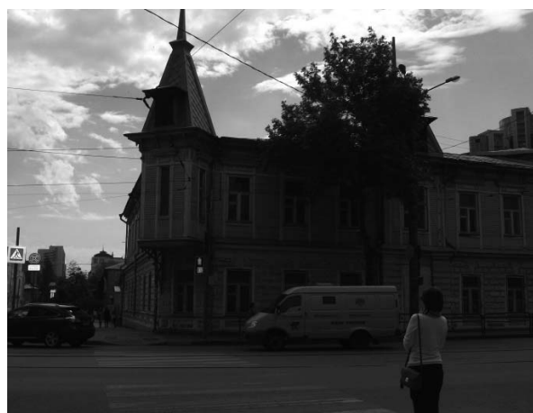
Рис. 4. Здание с эркером, покрытым деревянным шатром (ул. Галактионовская, д. 169)
