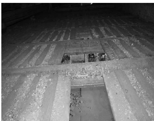
Рис. 12. Чердачное перекрытие. Виден накат чердачного перекрытия из толстых пластин (ул. Вилоновская, д. 24/102)
