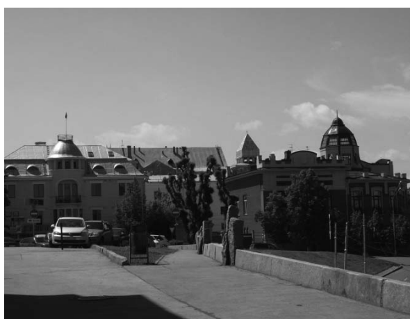
Рис. 18. Тонкостенный деревянный купол-оболочка особняка фон Вакано по ул. Шостаковича, д. 3 и светопрозрачный стальной ребристый купол здания по ул. Шостаковича, д. 1
