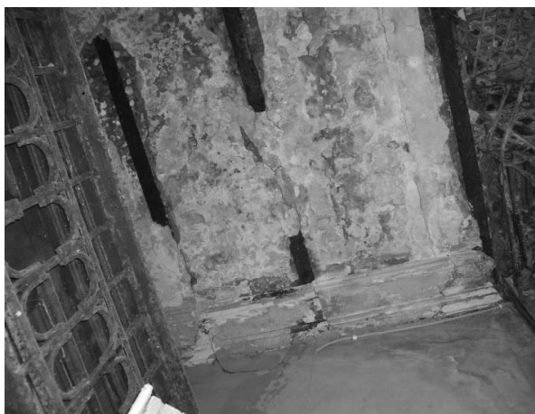
Рис. 13. Бетонное чердачное перекрытие по стальным балкам в здании по ул. Некрасовской, д. 24/102
