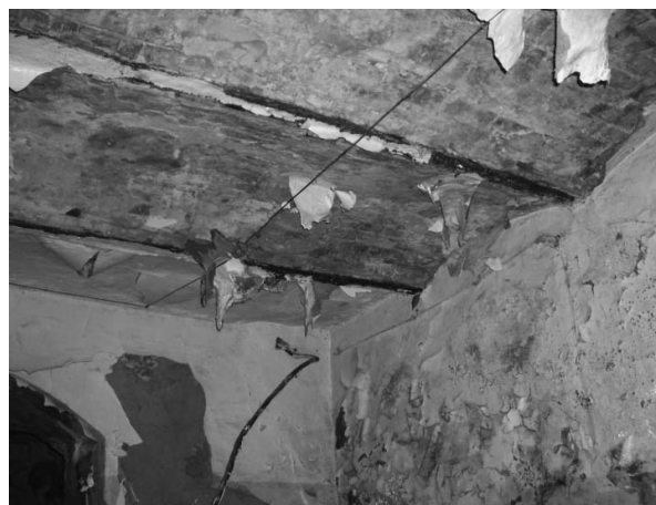
Рис. 2. Сводчатое многоволновое кирпичное перекрытие над подвалом (здание 1908 г. по ул. Венцека, д. 61)
