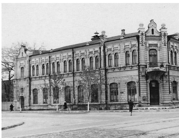
Рис. 3. Здание бывшего Архиерейского подворья, ул. Вилоновская, д. 24/102
