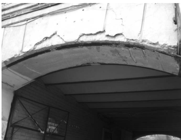
Рис. 15. Бетонное перекрытие типа Монье над дворовым проездом здания по ул. Галактионовской, д. 26
