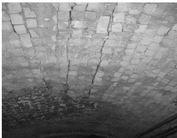
Рис. 14. Кирпичное перекрытие в виде цилиндрического свода над дворовым проездом здания по ул. Степана Разина, д. 45
