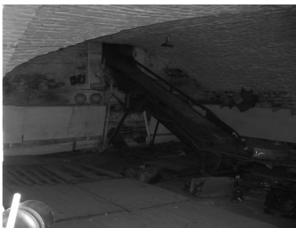
Рис. 9. Кирпичное перекрытие в виде сомкнутого свода над подвалом здания по ул. Галактионовской, д. 26
