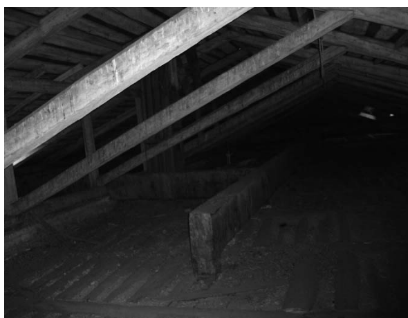
Рис. 16. Система наслонных стропил из брёвен (ул. Вилоновская, д. 24/102)
