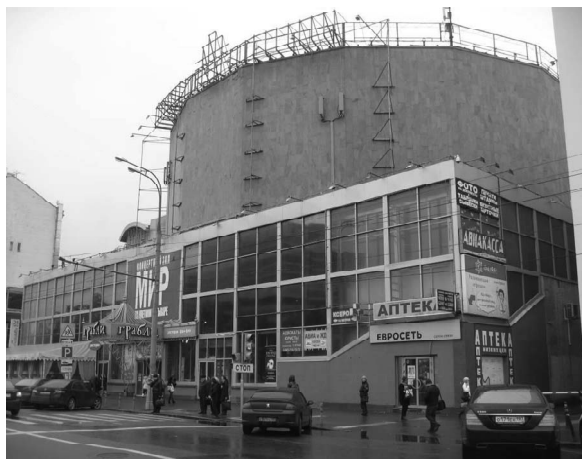
Рис. 1. Общий вид здания на Цветном Бульваре
